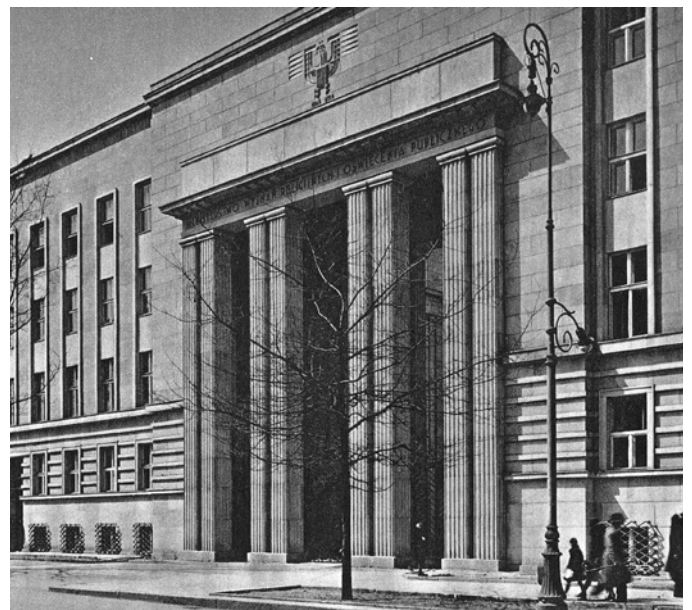
Budynek ministerstwa przy ul. Szucha (przed 1939 r.), w czasie okupacji siedziba gestapo
