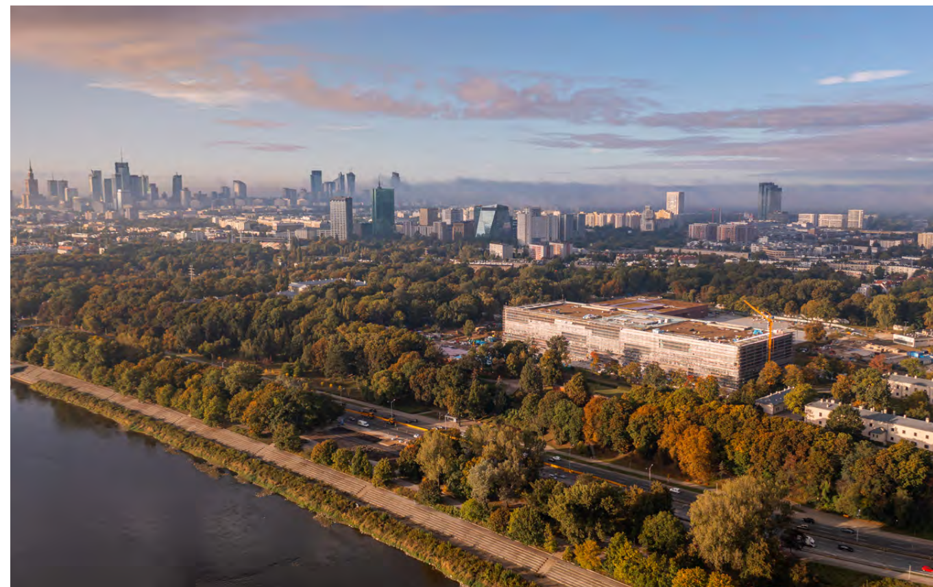
↑ Budowa siedziby Muzeum Historii Polski – widok z drona Construction of the seat of the Polish History Museum, a view from a drone
