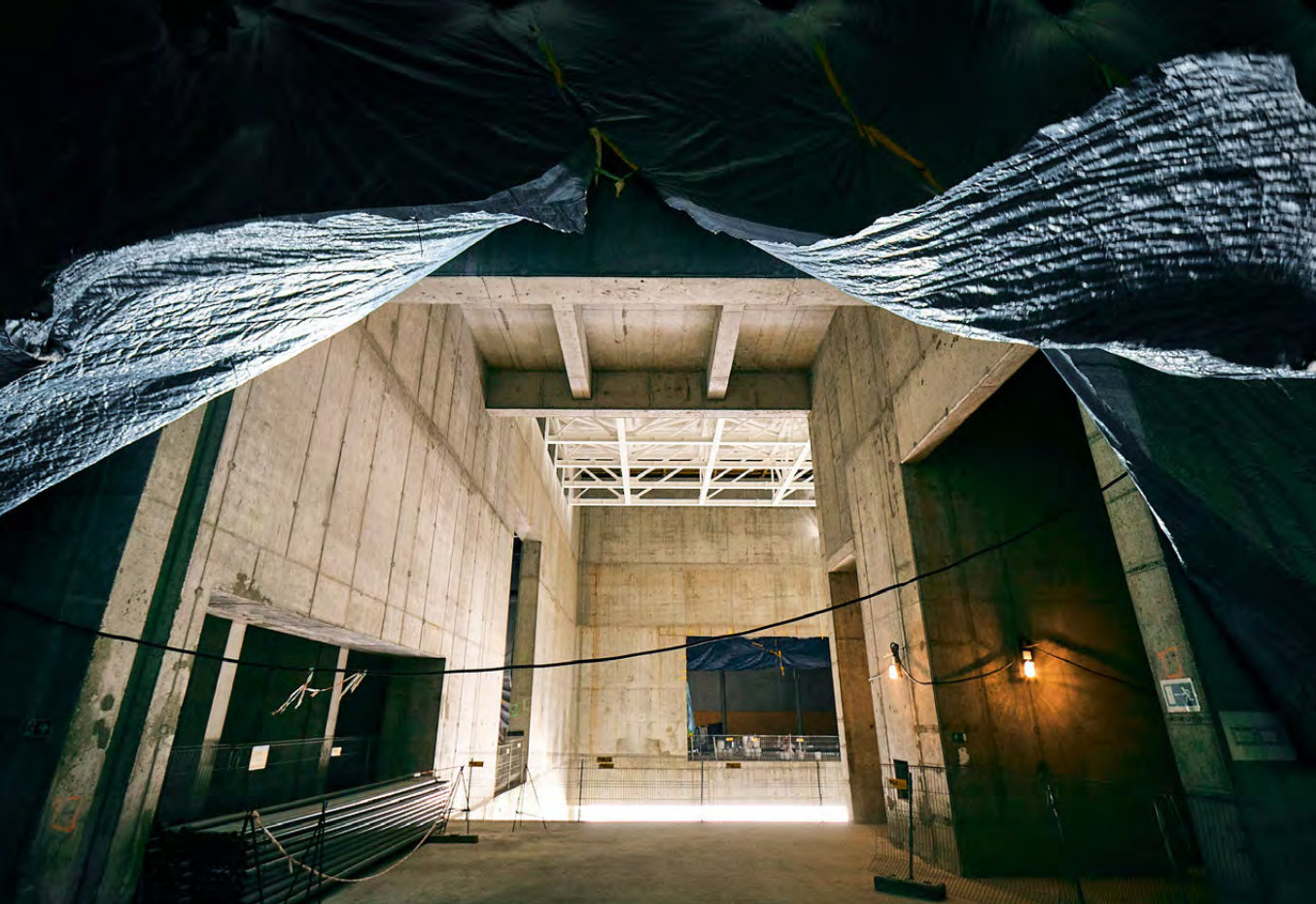
↑ Budowa siedziby Muzeum Historii Polski – hol główny Construction of the seat of the Polish History Museum, the main hallway
