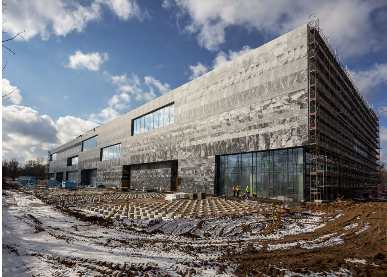
↓ Budowa siedziby Muzeum Historii Polski (elewacja od strony wschodniej) Construction of the seat of the Polish History Museum (the eastern façade), a view from a drone
