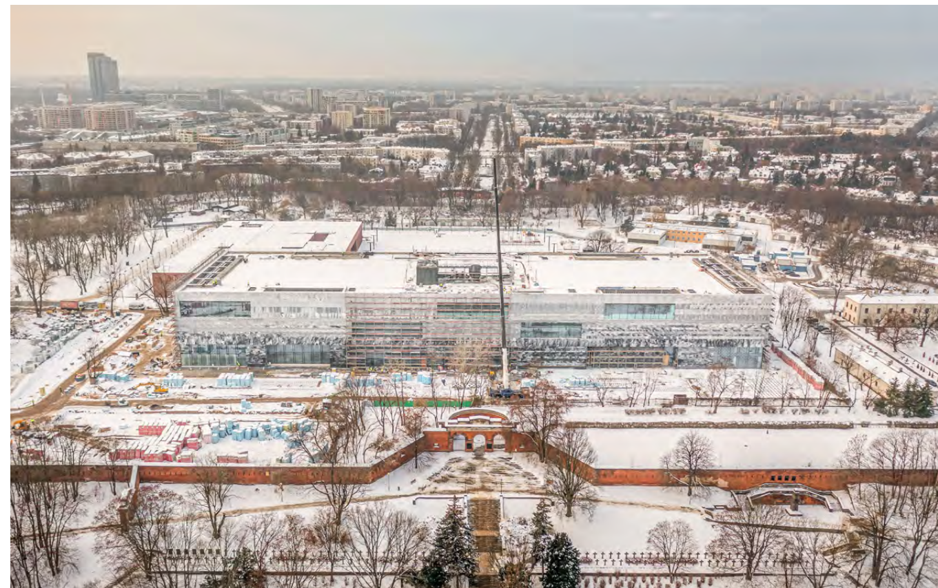
↑ Budowa siedziby Muzeum Historii Polski – elewacja od strony wschodniej Construction of the seat of the Polish History Museum (the eastern façade), a view from a drone
