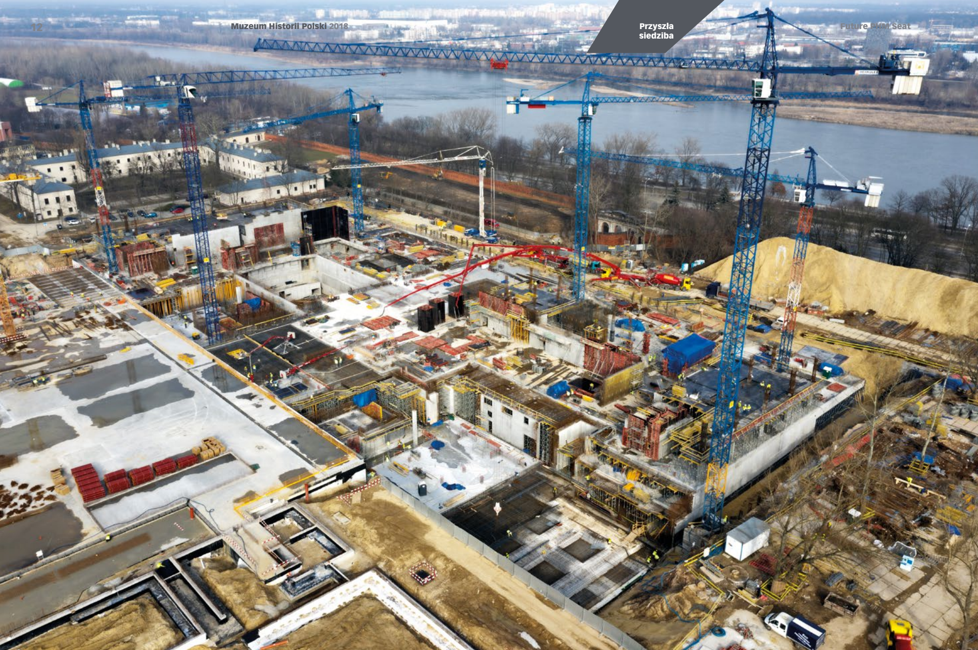
Budowa siedziby Muzeum Historii Polski – widok z drona / Construction of the seat of the Polish History Museum, a drone aerial view
