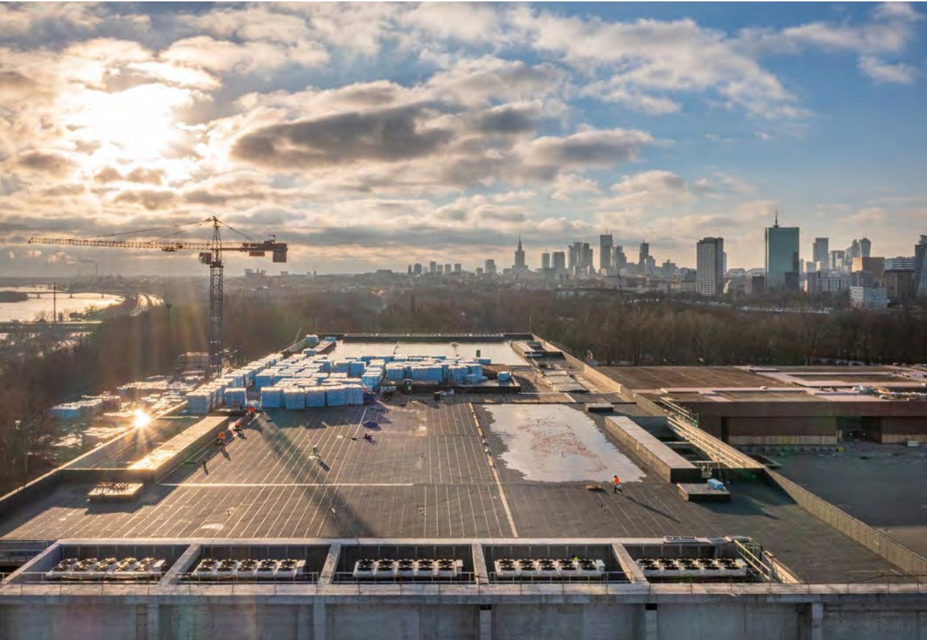
↑ Budowa siedziby Muzeum Historii Polski – widok z drona Construction of the seat of the Polish History Museum, a view from a drone
